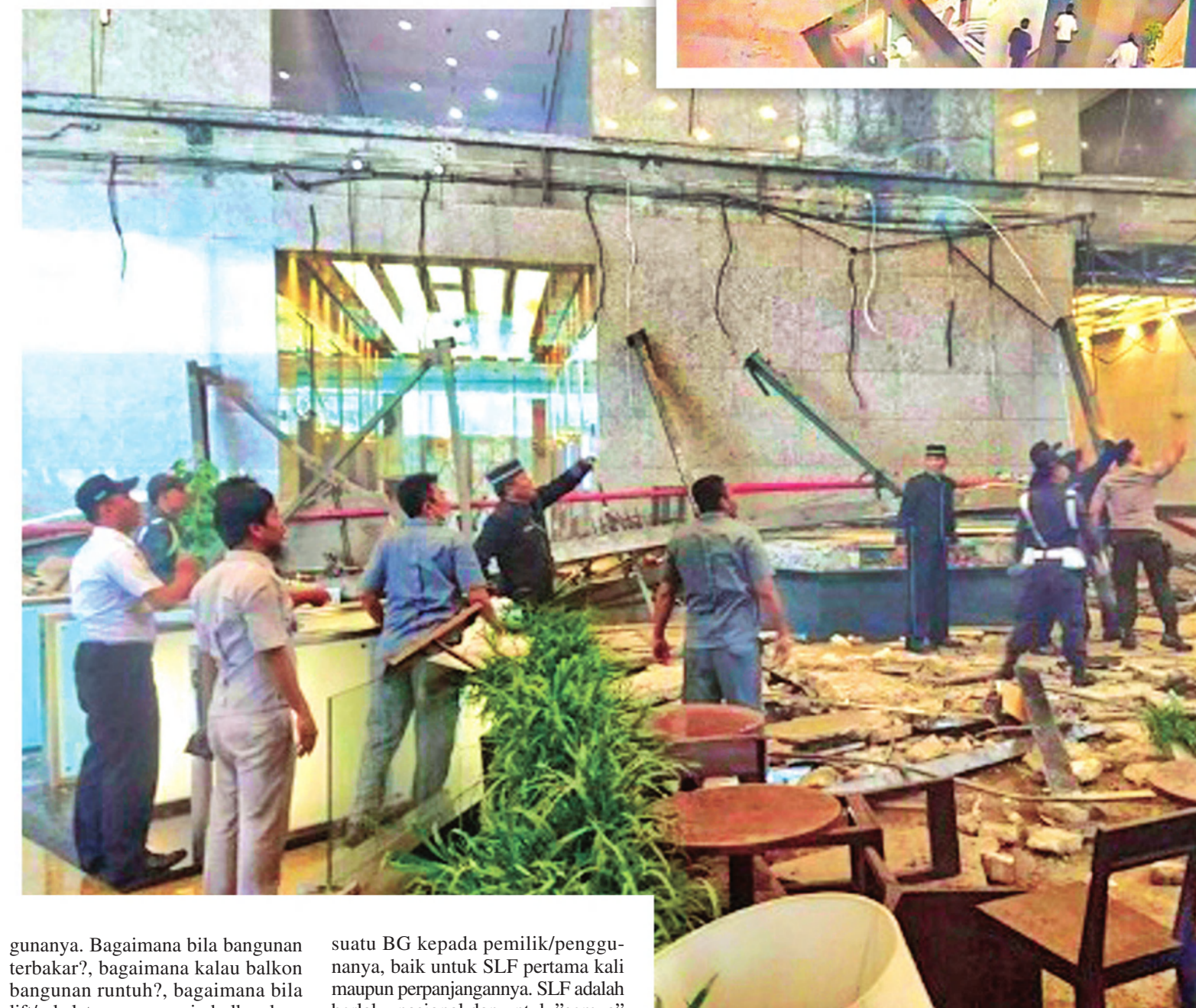
Kondisi saat kegagalan bangunan (Pukul 11:56:42 WIB) Sling terlepas/putus Dari suspended bagian atas.
